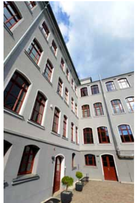
Außenansicht der ehemaligen Weberei
