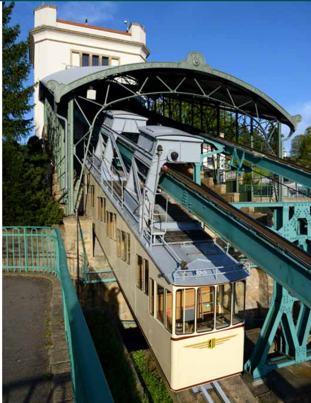
Bergstation der Schwebbahn
